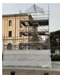
Il cantiere per il restauro
